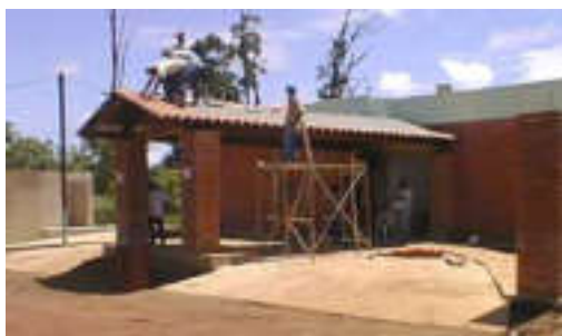
Centro de salud, en el estado de Bolívar, Venezuela. Construido a través de una alianza tri-sectorial entre la empresa minera (Placer Dome y CVG), el gobierno regional, las comunidades locales, ONGs y el ejército.
